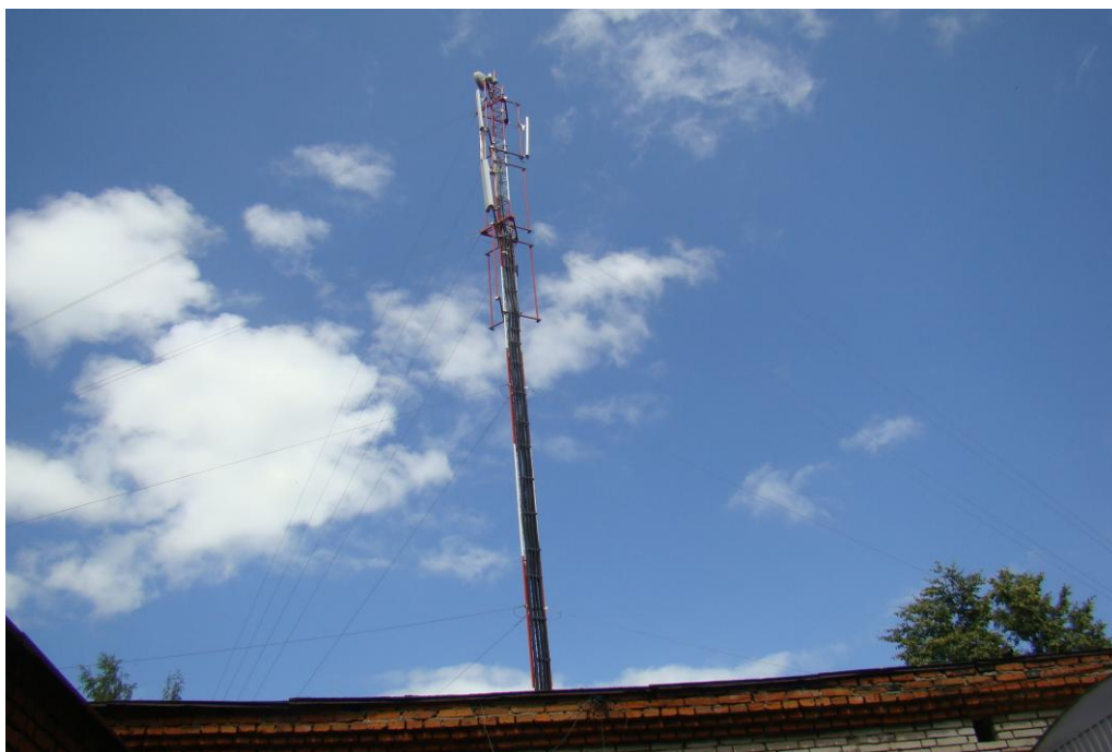
Рис.2 Мачта сотовой связи до обрушения
