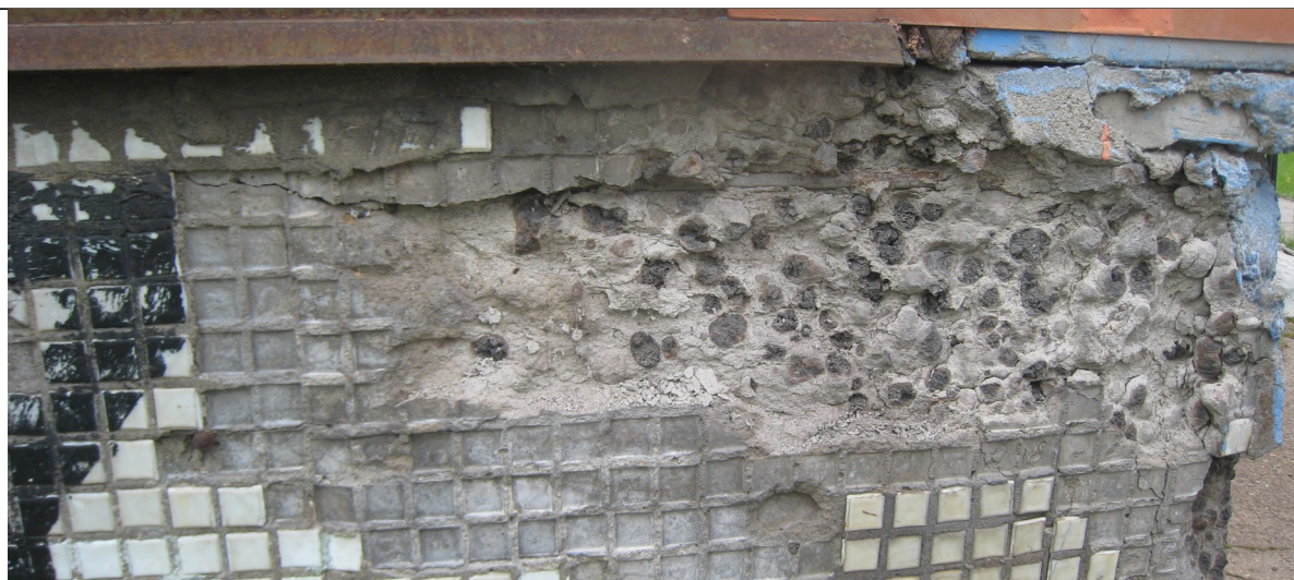
Рис.2. Частичное разрушение керамзито-бетонной стеновой панели
