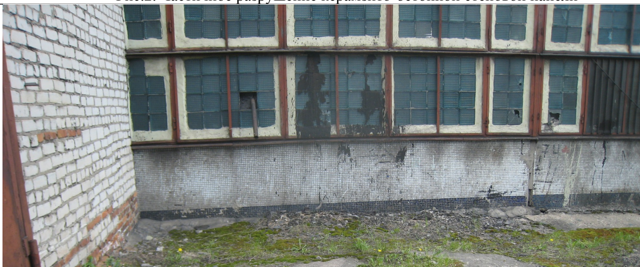
Рис.2. Частичное разрушение керамзито-бетонной стеновой панели
