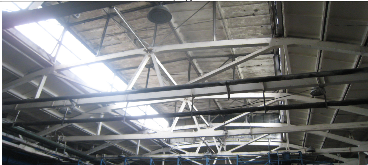
Рис.4 Общий вид стропильных конструкций
