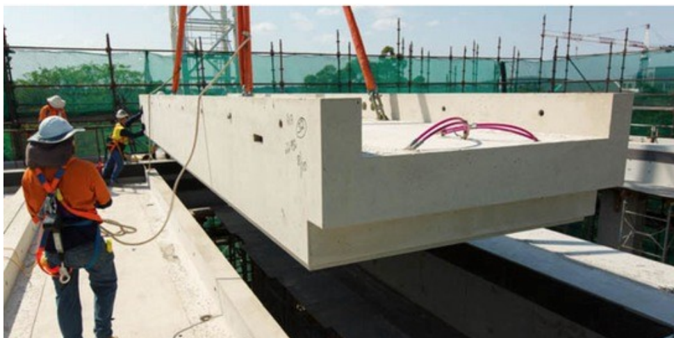
Рис.1. Монтаж плиты перекрытия, изготовленной из геополимерного бетона на основе золы и шлака [6]
