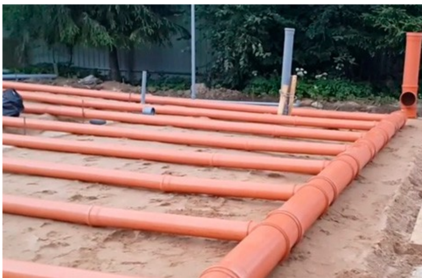
а) Канальный теплообменник с несколькими параллельными трубами.
