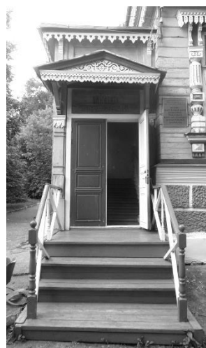
Рис. 21. Входная группа. Восточный фасад.
