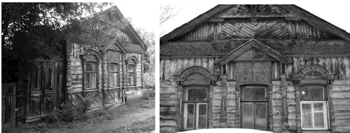
Рис. 6. Дом по ул. Гладкова, 24. Современное состояние.
