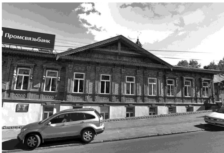
Рис.2. г. Пенза, дом по ул. Володарского, 9. Современное состояние.
