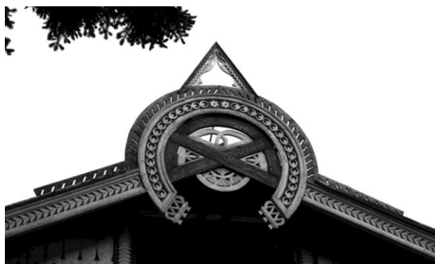
Рис. 7. Фрагмент конька фронтона мезонина
