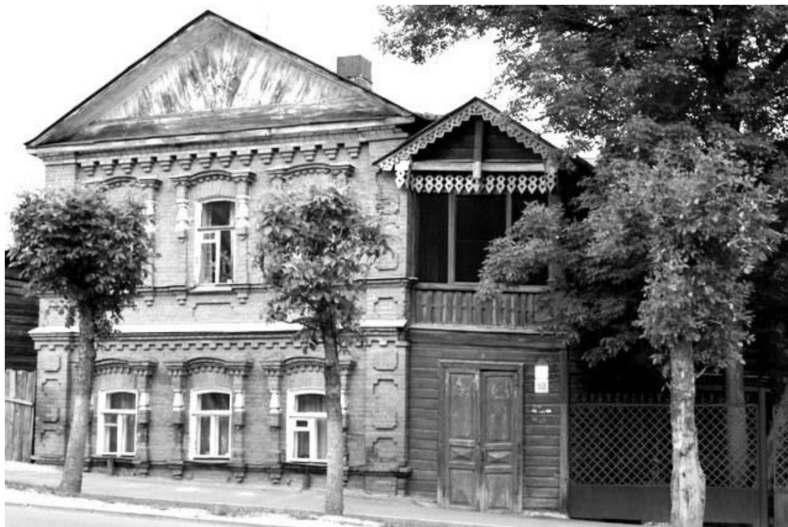
Рис.1. Вид на объект культурного наследия местного (муниципального) значения «Дом жилой, вторая половина XIX в.» с ул. Куйбышева (г. Пенза)
