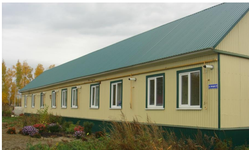
Рис.1. Каркасно-щитовой жилой дом в г. Сурск Пензенской области.
