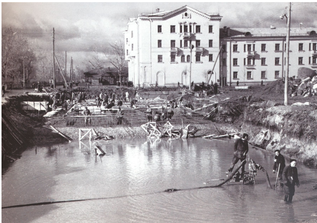
Рис.1. Закладка дома по ул. Пушкина на углу с ул. Володарского
