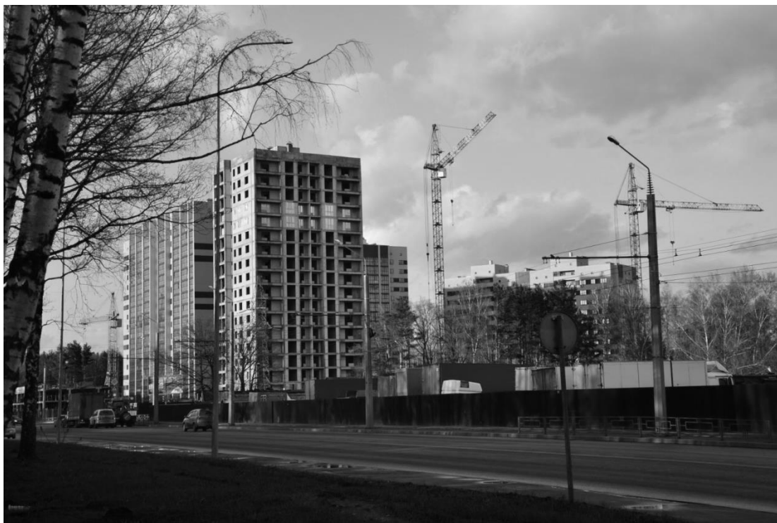
Рис. 1. Комплекс жилой застройки «Прилесный» в процессе строительства.
