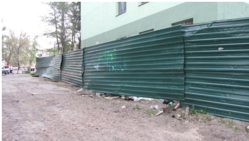
Рис. 3. Типичное ограждение стройплощадки в Пензе
