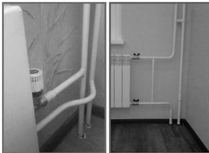
Рис. 1. Стояк вертикальной системы отопления
