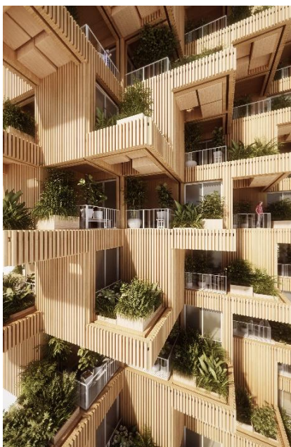
Рис. 3. Башня деревьев дом из модулей клееного дерева на 500 квартир. Канада, г. Торонто.
