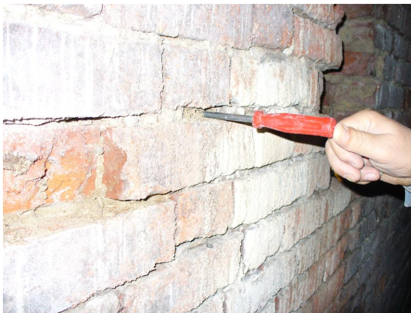
Рис. 3. Кладочный раствор засолённой стены настолько слаб, что легко поддаётся под небольшим усилием
