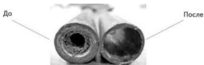
Рис. 1. Результат выполнения промывки системы отопления
