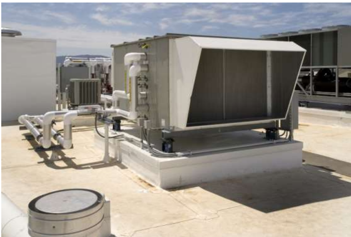
Рис. 1. Установка руфтопа
