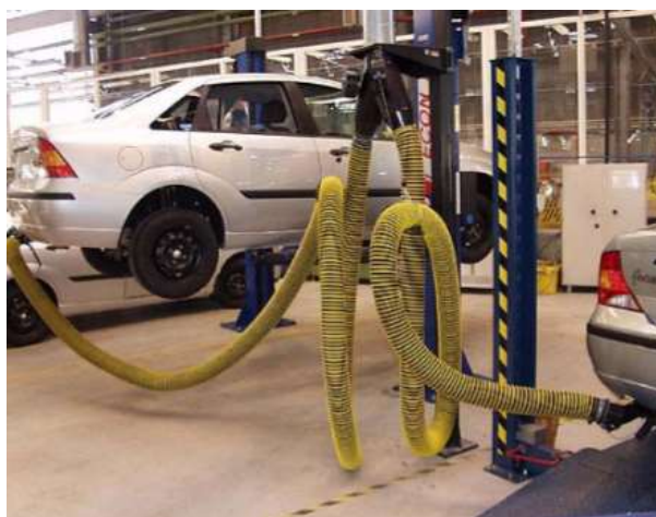
Рис. 1. Вытяжное устройство «Dropper» для обслуживания двух рабочих мест
