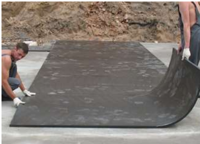
Рис. 2. Укладка матов Sylomer на предварительно очищенное основание
