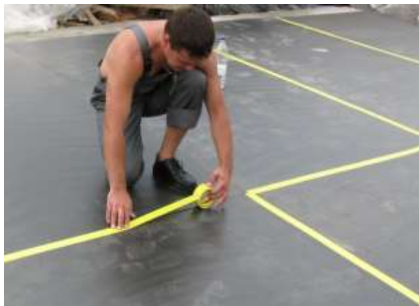
Рис. 4. Заклеивание стыков армированным строительным скотчем
