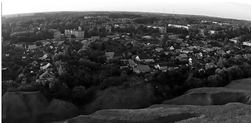
Рис. 2. Оползневый процесс на овраге «Лысая гора»
