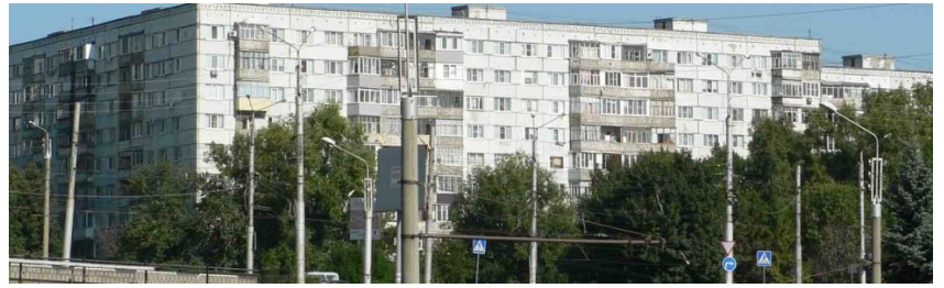
Рис. 10. Многоэтажный жилой дом по ул. Карпинского
