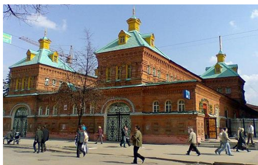
Рис. 3. Здание по ул. Московская, 85. "Русский" стиль
