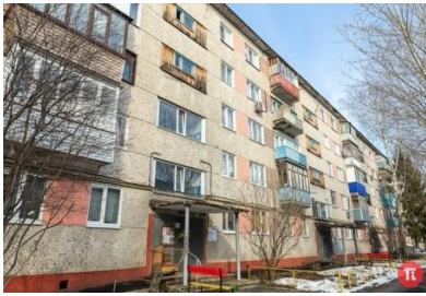
Рис. 9. Панельная пятиэтажка по ул Карпинского
