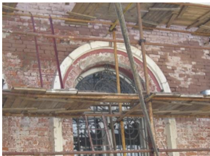
Рис. 1. Реконструкция кирпичной кладки и декоративных элементов при восстановлении храма
