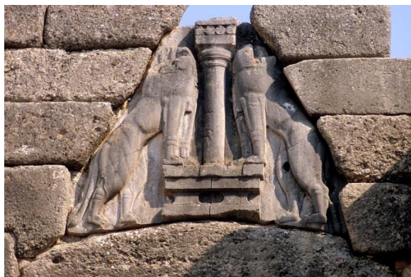
Рис. 4. Львиные ворота в Микенах. XVI век до нашей эры. Микены – город на морском побережье острова Крит Древней Греции. Каждый вышележащий ряд камней выступает относительно нижележащего ряда. Для исключения «слома» торцы стесаны под углом 60^{\circ} , таким образом, уменьшается величина изгибающего момента. Источник [5].
