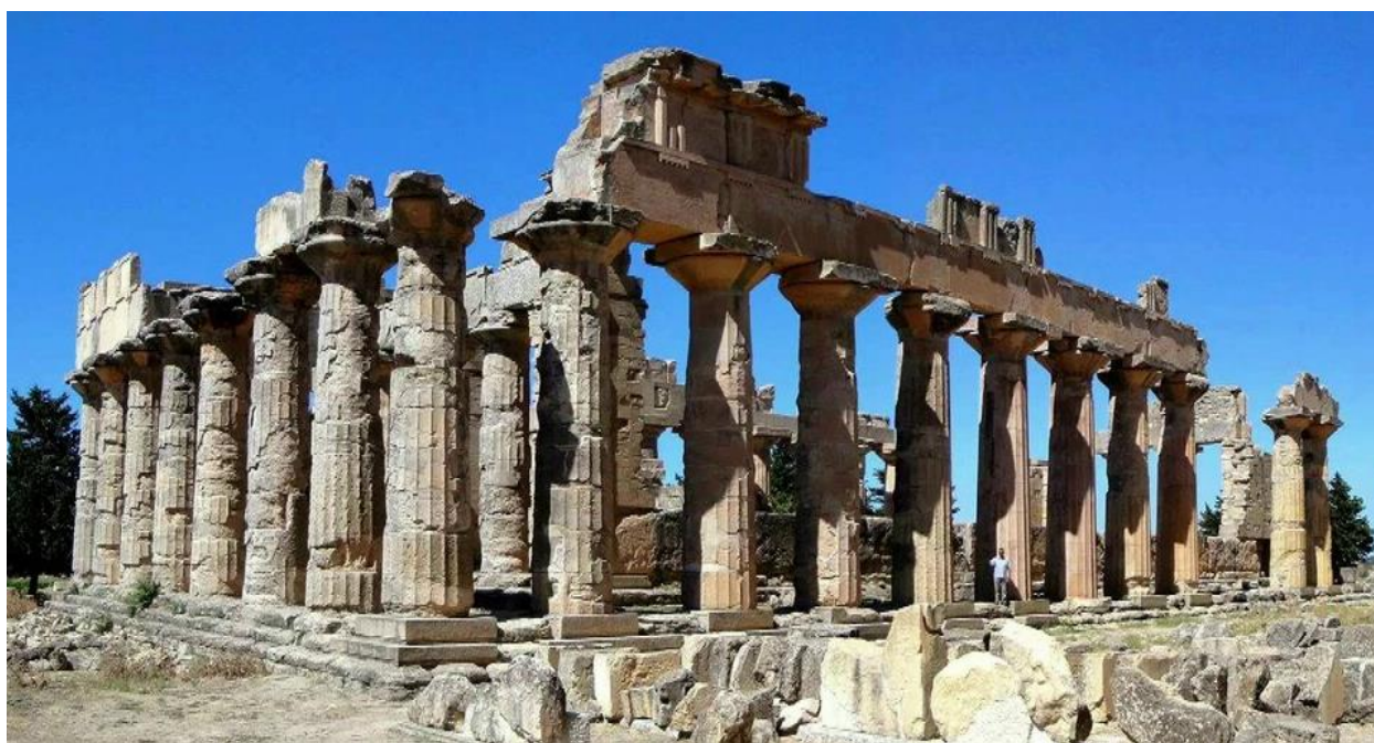
Рис. 2. Стоечно-балочная система в Древней Греции. Сложенные из камней колонны выполнены в строгом дорическом ордере. Балки – каменные блоки. Шаг колонн определяется размерами каменных блоков, плохо работающих на растяжение. Расширяющиеся кверху капители позволяют увеличить размер шага колонн. Балки и стропила двускатной кровли выполнялись из дерева. Источник: Barletta, В. А. (2011). "Greek Architecture." American Journal of Archaeology . Volume 11. Issue 54. Pp.11–40.
