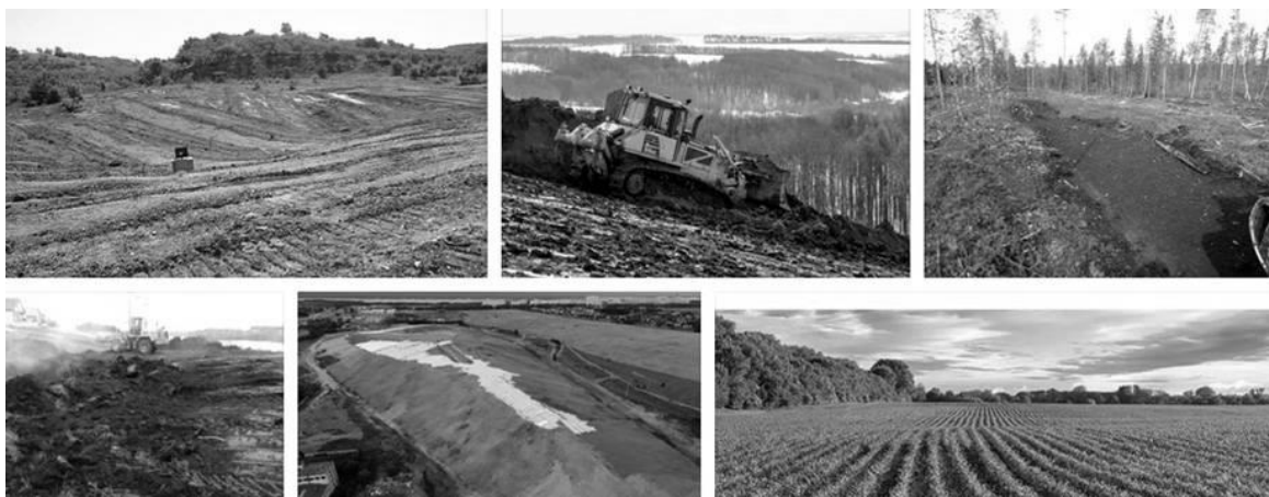
Рис. 2. Рекультивация земель после буровых работ
