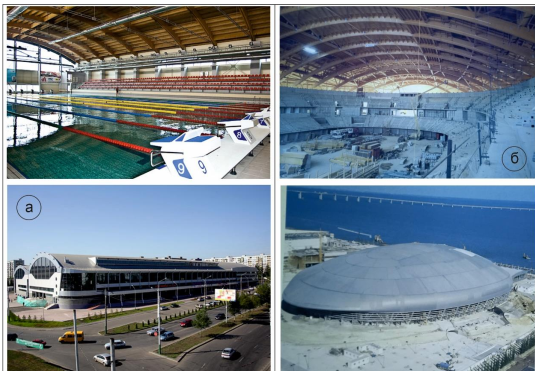
Рис. 3. Большепролетные клееные деревянные конструкции в покрытиях спортивных и выставочных сооружений
