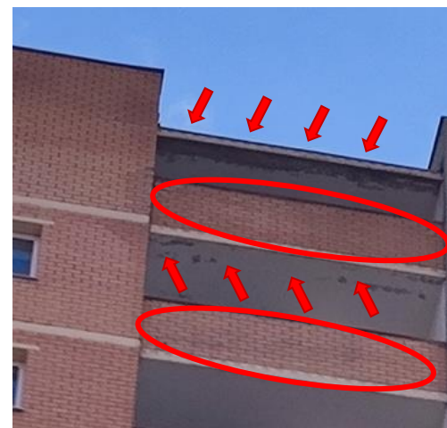
Рис 5. Замачивание конструкций стен и плит
