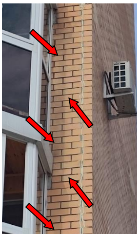
Рис 4. Трещины в кирпичной кладке
