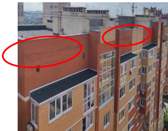
Рис. 1. Замачивание кирпичной кладки
