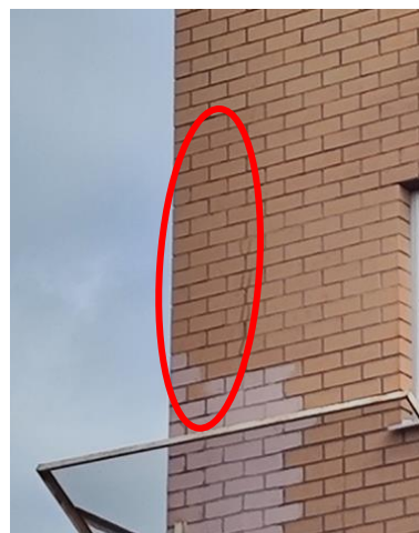
Рис 4. Трещины в кирпичной кладке
