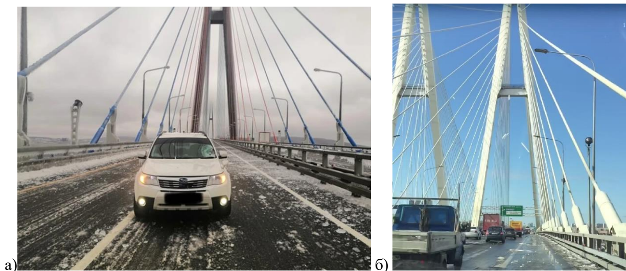
Рис. 1. Падение льда на проезжую часть: а – на Русском мосту в г. Владивосток, б – Большого Обуховского моста в г. Санкт-Петербург
