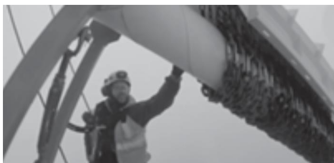
Рис. 5. Установка цепных воротников на подвеске в верхней части ванты
