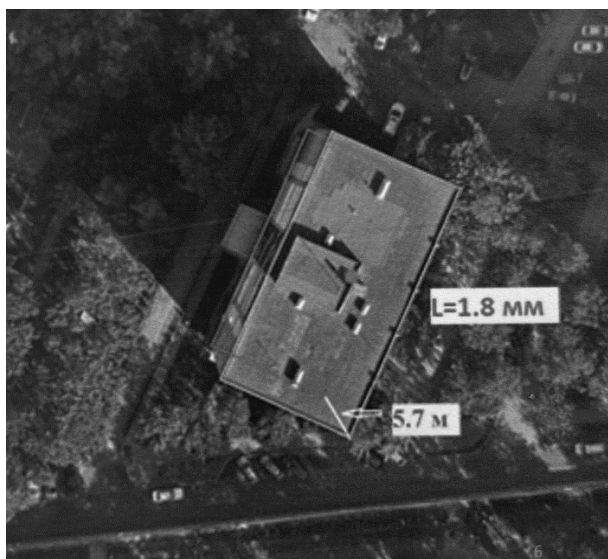
Рис. 6. Ортофотоплан многоэтажного здания АФС с БПЛА
