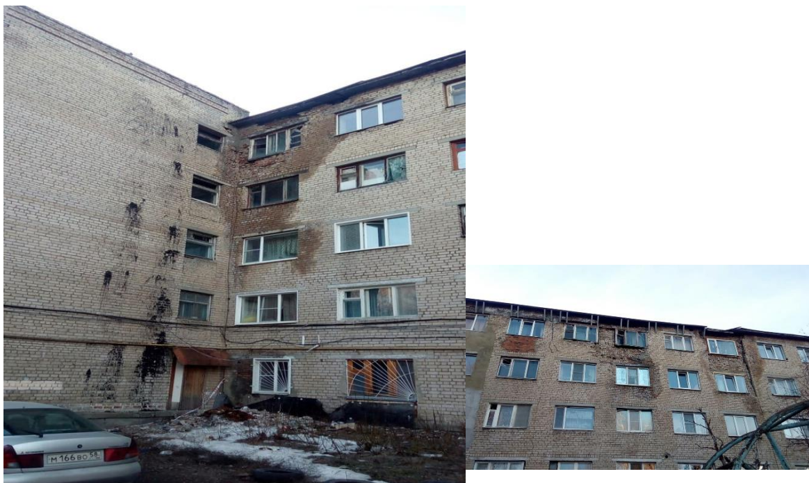
Рис.1. Состояние объекта до осуществления ремонтных мероприятий
