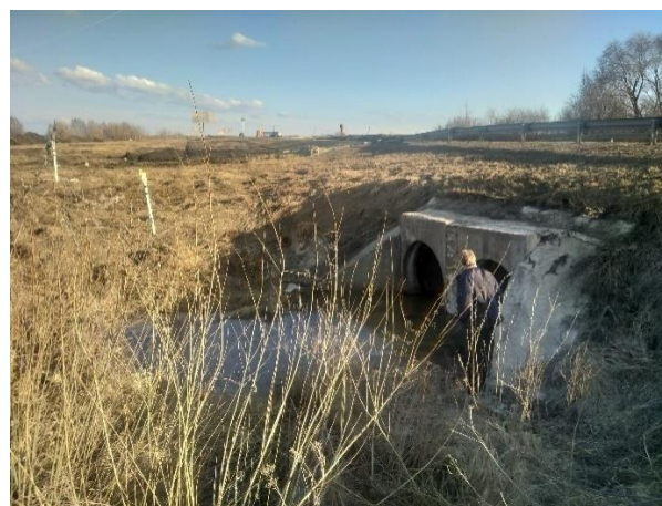
Рис.1, 2. Входной и выходной оголовки трубы на пикете 16+26
