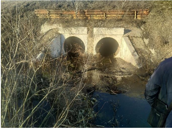
Рис. 3, 4. Входной и выходной оголовки трубы на пикете 33+56
