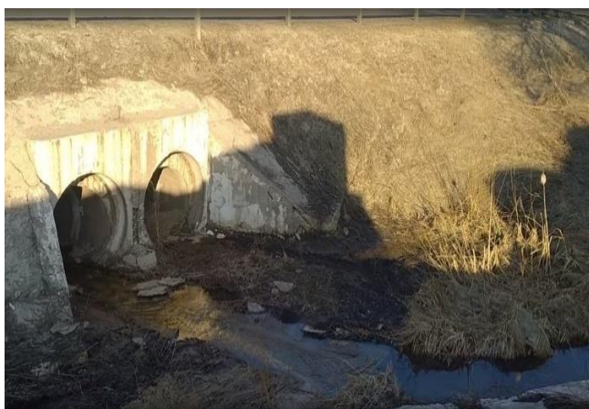
Рис.1, 2. Входной и выходной оголовки трубы на пикете 16+26
