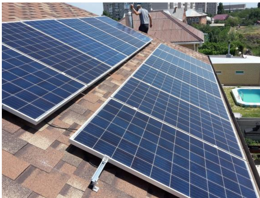
Рис. 1. Установка солнечных панелей на крыше
