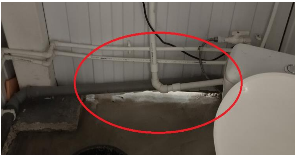
Рис. 3. Наличие щелей между перегородкой и уровнем пола
