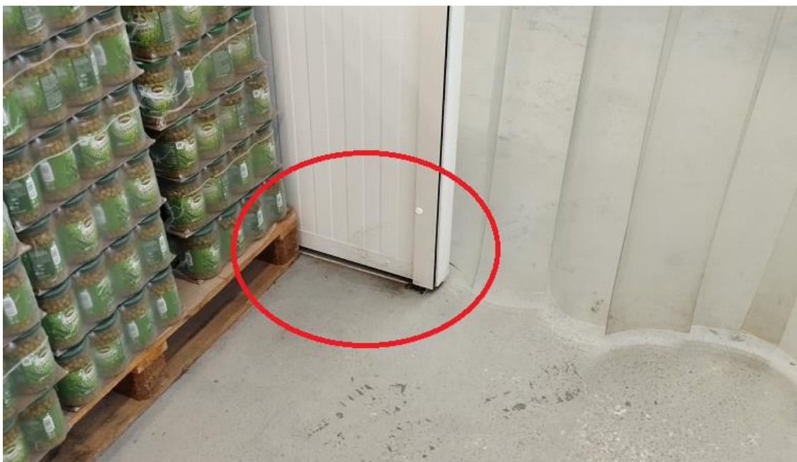
Рис. 2. Наличие щелей между перегородкой и уровнем пола
