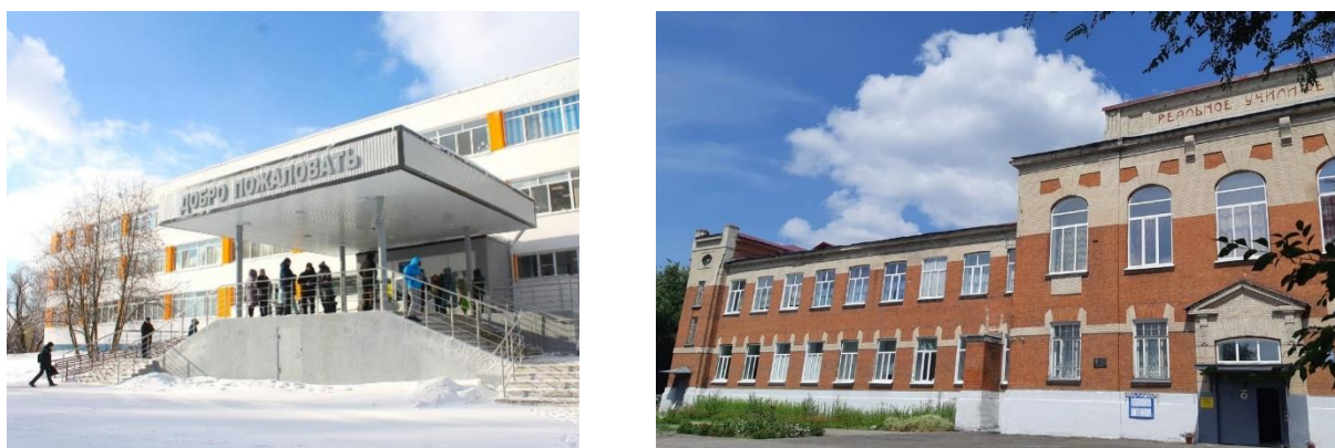
Рис. 1. Отремонтированные здания школ в Пензенской области
