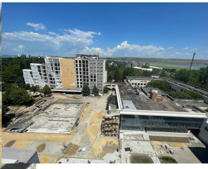
Рис. 2. Бассейн во время проведения строительно-монтажных работ
