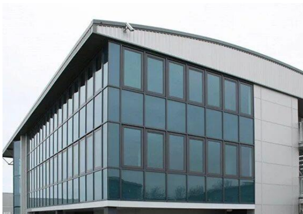
Рис. 1. Вид современных оконных конструкций в промышленных предприятиях
