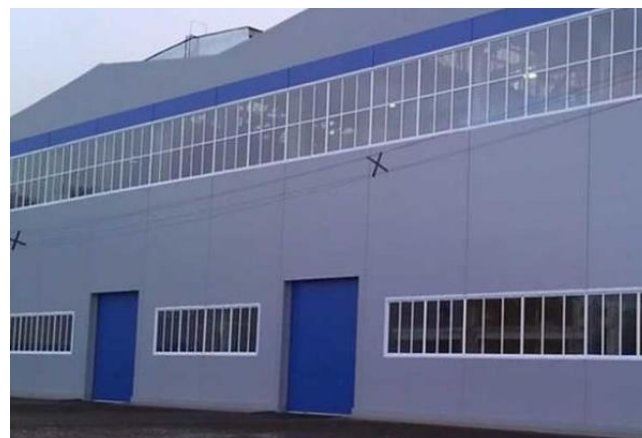
Рис. 2. Вид современных оконных конструкций в промышленных предприятиях
